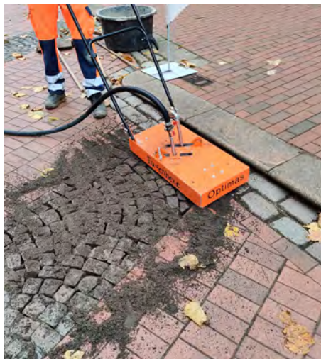
Die Optimas Fugenhexe reinigt Fugen tief, gleichmäßig und ohne Sand oder Steine umherzuwirbeln.
