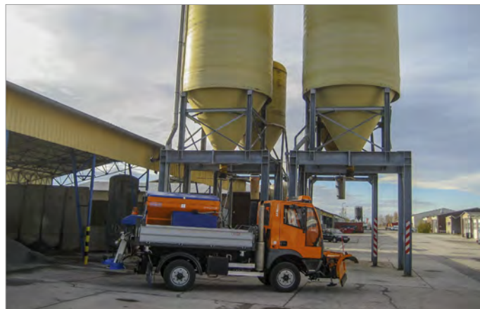
Für den Winterdienst in Bitterfeld-Wolfen lagern auf dem Areal des Stadthofs 225 Tonnen Salz in den Silos, 30.000 Liter Sole im Tank sowie 50 Tonnen Splitt.
